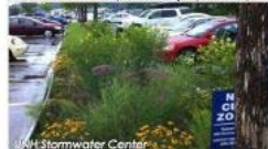
Bioretention Retrofit, UNH Campus, Durham, NH
